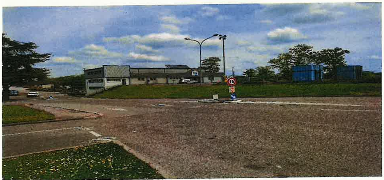
Quai de transfert – vestiaires
